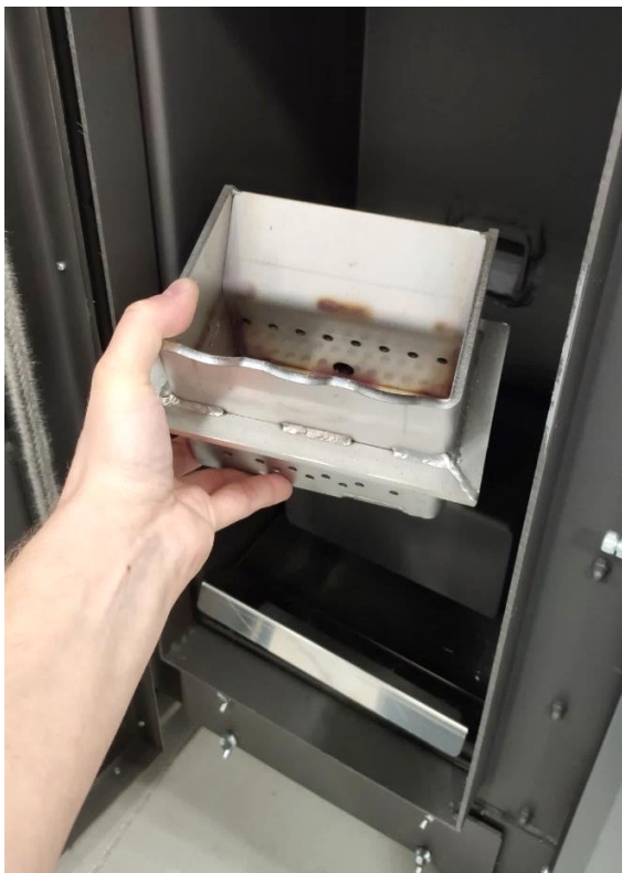
Czyszczenie rusztu w kotle
