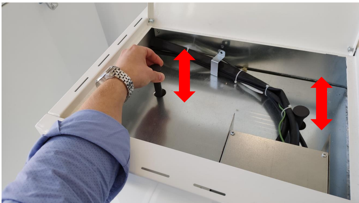
Czyszczenie zawirowywaczy spalin
